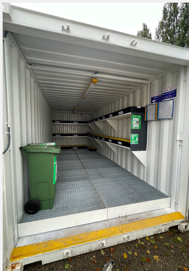
> RÉALISATION AMÉNAGEMENT CONTAINER
